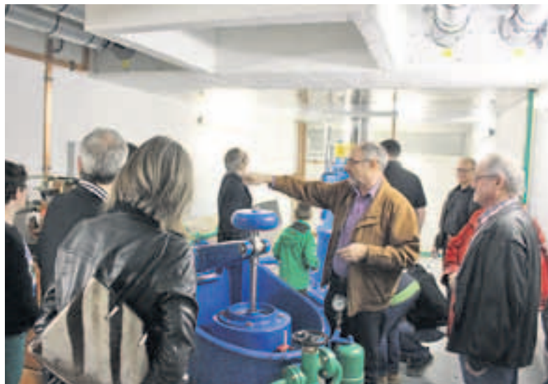
Alois Züger führt die Märchler Liberalen durch die Anlage des Kraftwerks Rempen.
